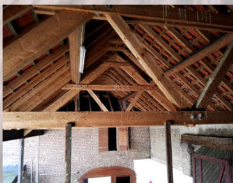
Neuer Dachstuhl zur Reithalle
