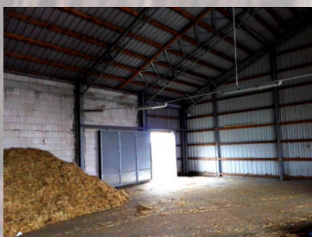
Innenansicht neue Lagerhalle
